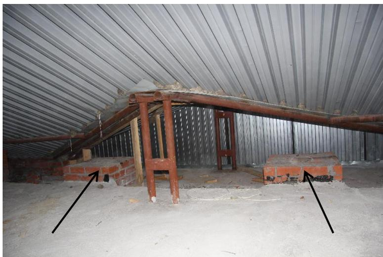
Фото №14.Промежуточные опоры под P-2 по оси В-В отсутствуют при наличии тумб и закладных.
