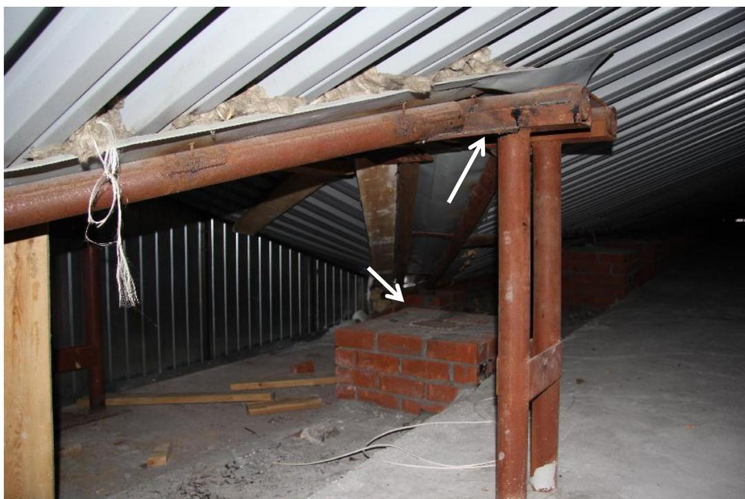
Фото №19. Неправильно установленные при строительстве косынки , отсутствие антикоррозионной обработки, отсутствие промежуточных опор под R2.
